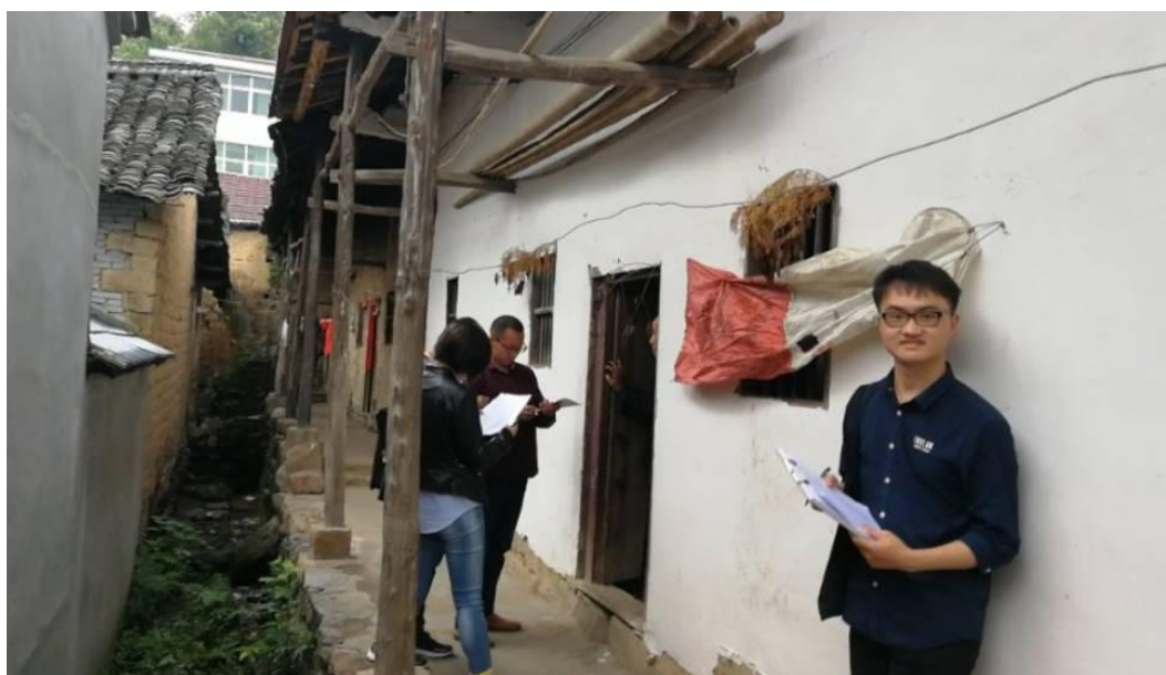
麻城精准扶贫社会实践危房鉴定现场照片
